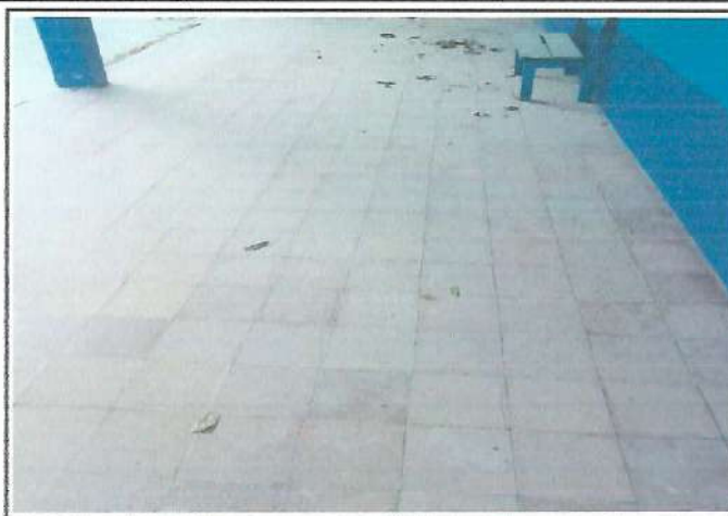
Foto 2: MEJORAMIENTO Y SUSTITUCIÓN DE PISO
