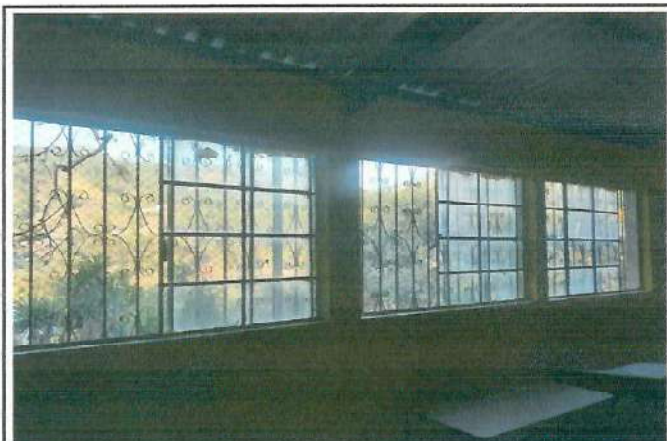
Foto 3: MEJORAMIENTO DE VENTANAS
