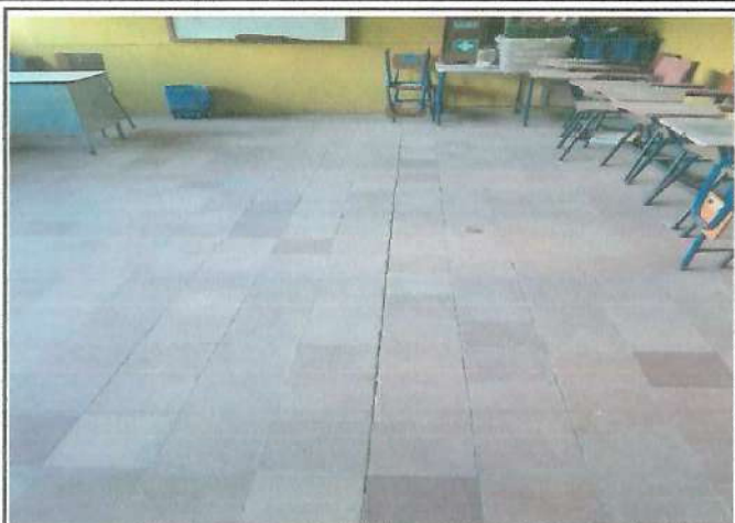
Foto 1: MEJORAMIENTO Y SUSTITUCIÓN DE PISO
